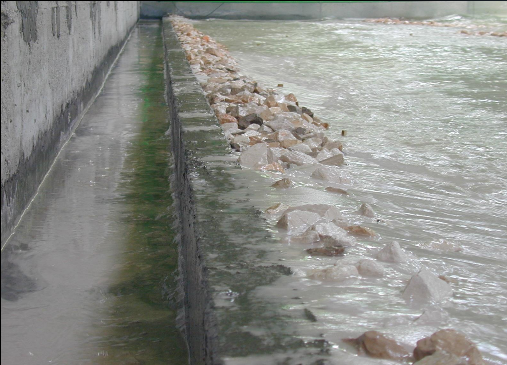
Stato iniziale delle opere. Si nota la tracimazione di acqua e sabbia sulla strada litoranea durante un attacco ondoso con H_s=4,5 m.
